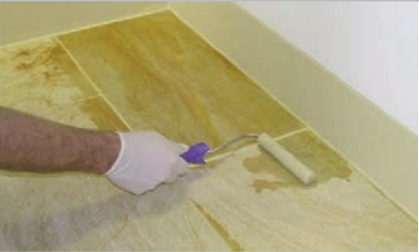
Das frisch verlegte FLEXSTONE Sandsteinvlies wird umgehend mit COETRANS Transparent Grundierung überarbeitet.
